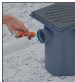
**Passo 6:** Ligue os tubos na caixa: siga recomendações Tigre para execução de juntas em instalações de esgoto. Junta dupla atuação, soldável ou com junta elástica.
