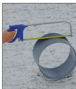
**Passo 1:** Se necessário, corte o prolongador no local indicado, usando um arco de serra. O prolongador pode ser cortado a cada centímetro.
